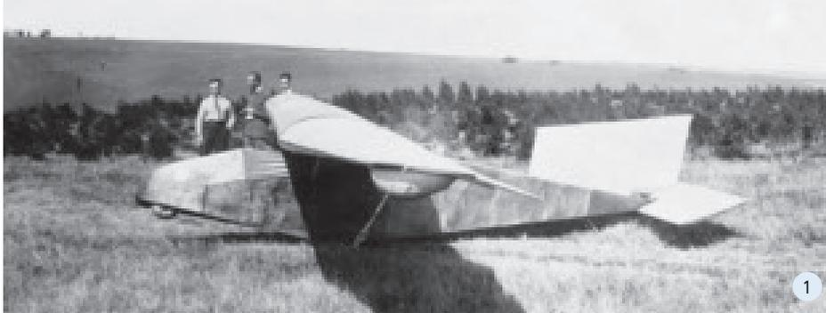
1: Der Vampyr mit seinem typischen Fahrwerk und der Lederverkleidung des Cockpits
